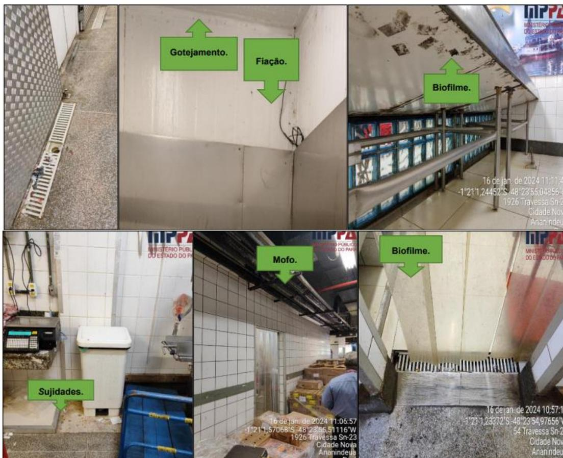
Figuras 10, 11, 12, 13, 14 e 15 CAOTEC/ GATI: Estrutura física.
